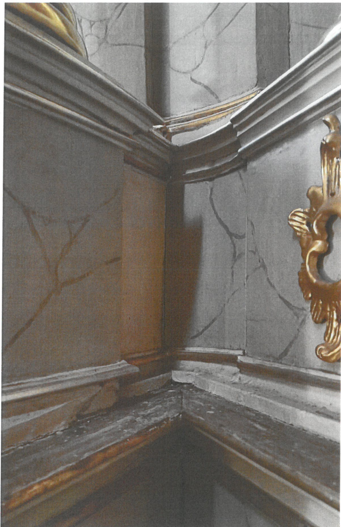
Fot.5. Targowiska, Kościół Parafialny p.w Św. Małgorzaty, ołtarz główny, fragment. Widoczne rozluźnione połączenia stolarskie Stan przed konserwacją. Fot. Katarzyna Kasperkiewicz, luty 2023.
